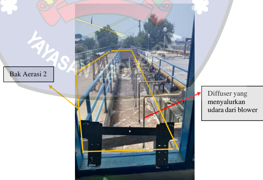
Gambar 10. Kondisi Eksisting Bak Aerasi 2 (Sumber:PPSNZJ)
