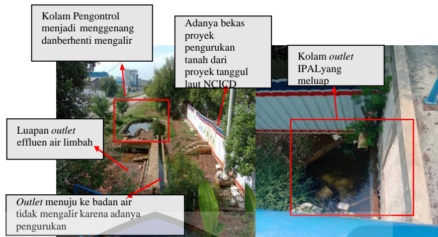
Gambar 20. Kondisi Eksisting Kolam Pengontrol. (Sumber PPSNZJ)
