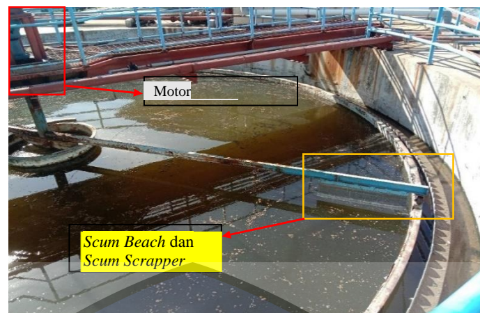
Gambar 12. Kondisi Eksisting Bak Pengendap Akhir (Sumber : PPSNZJ)
