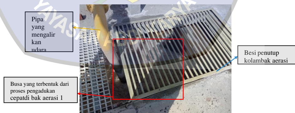
Gambar 15. Busa yang terbentuk pada Bak Aerasi 1 dari proses pengadukan cepat. (Sumber PPSNZJ)
